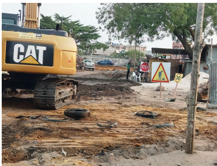
Photo N° 02 : Panneaux temporaires de chantier
