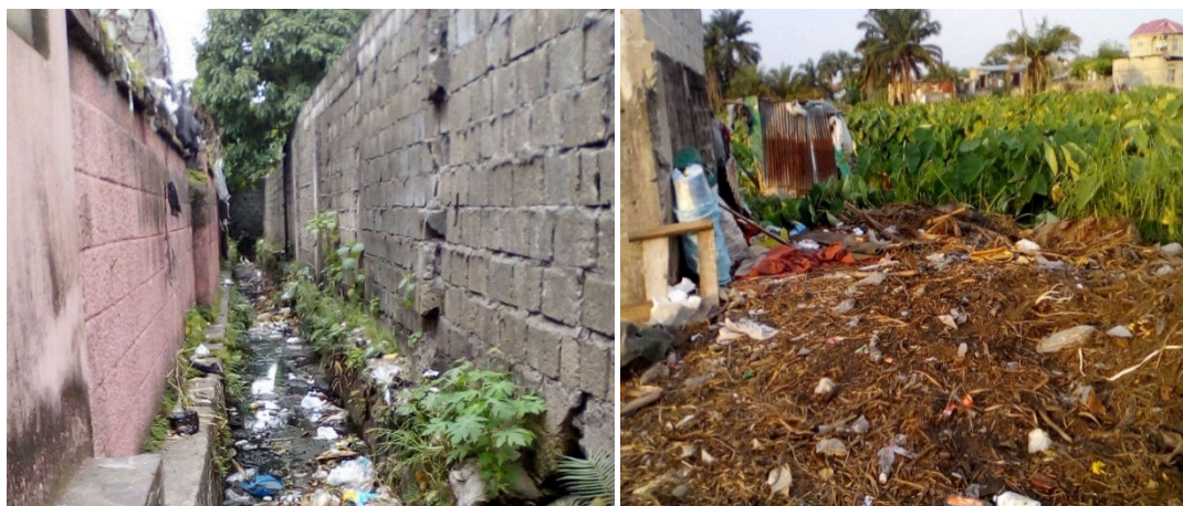
Photo 9 et 10 : caniveau bouché coincé entre deux murs + hangars d'occupation anarchique au sein du BSN
