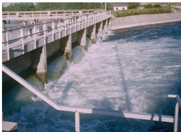
Fig. 3. Localisation Barrage mobile en amont du canal Tri-State
