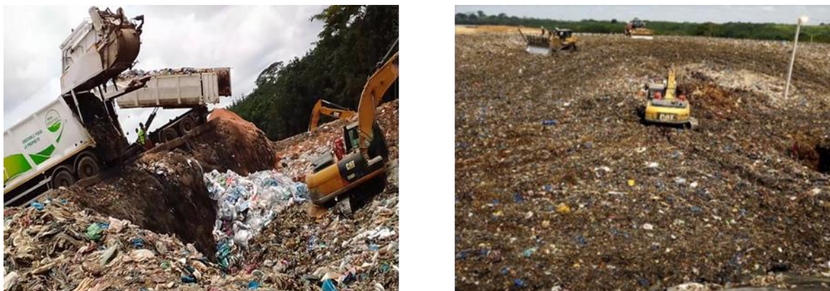
Fig. 9. Aperçu d'un casier du Centre de valorisation et d'enfouissement technique de Kossihouen
