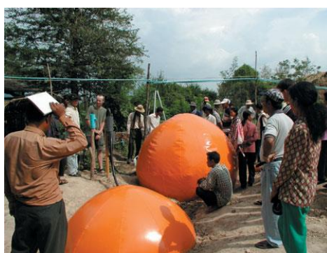
Fig. 2. Installation du prototype, sous forme d'un énorme ballon plein de déchets animaux, auquel est accrochée une lampe pour fournir l'éclairage
