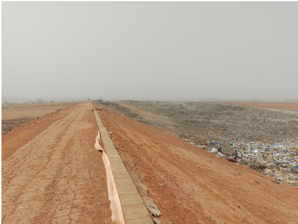
Image 1: Décharge contrôlée compactée de Noumoubougou: Bassin contenant les déchets stockés à l'air libre dégageant des fumées et odeurs nauséabondes pendant la saison sèche.
