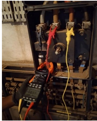
Fig. 2. Multimètre MS2205 connecté au sectionneur jeu de barres
