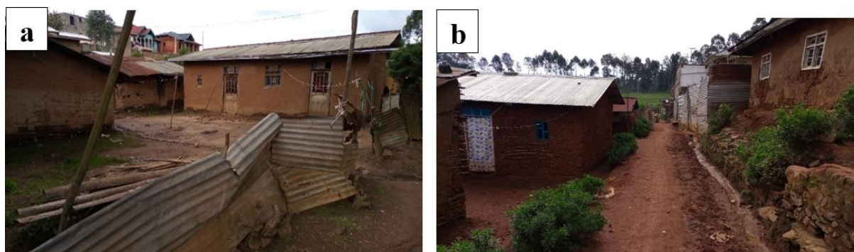
Fig. 1. Maisons construites en terre battue non entretenue utilisant des tôles usées comme clôture au quartier Lumumba sur l'Avenue Lubero (a) et dans la cellule Kaluvu (b)
