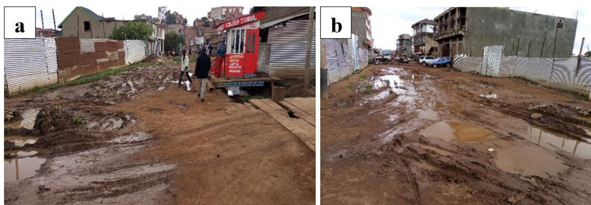
Fig. 2. Aperçu de l'Avenue Rwenzori avec une route en état de dégradation avancé et non praticable par des piétons (a) et des engins de deux roues (b) au quartier Lumumba
