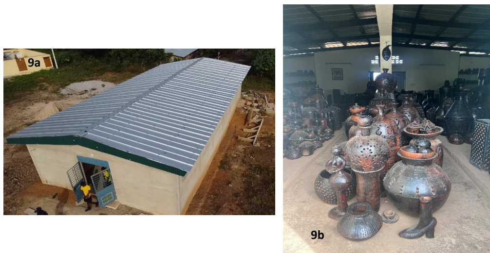
Fig. 9. Des vues de l'extension en cours de construction et des objets de la salle principale d'exposition au centre artisanal des potiers de Tanou-Sakassou
