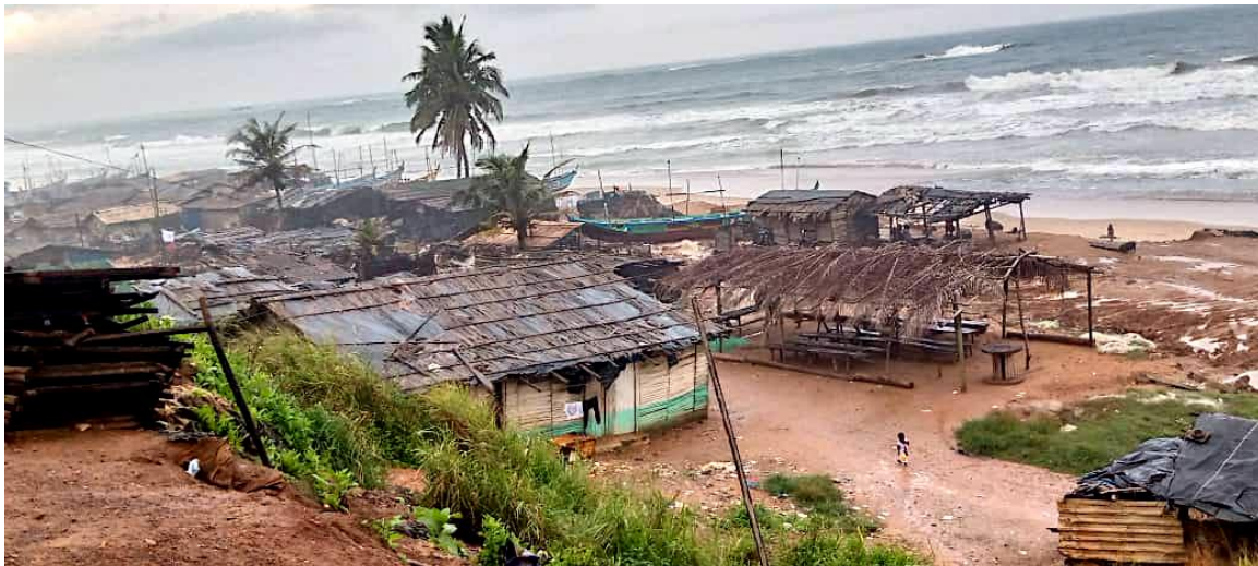
Fig. 7. Avancement de l'eau vers les habitations des villageois
