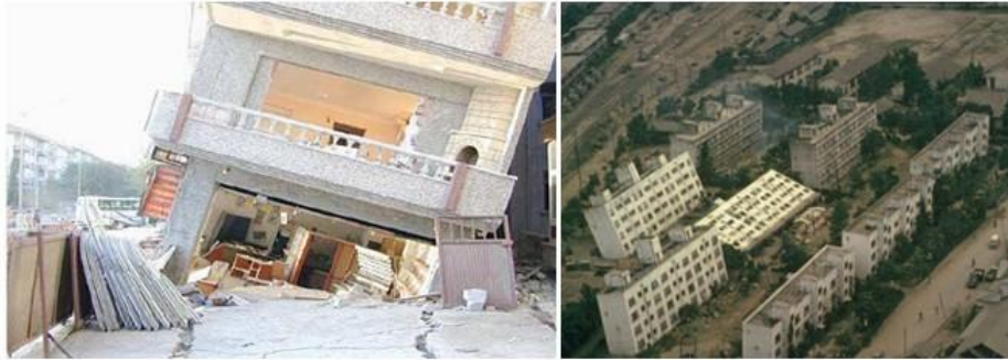
Fig. 2. Renversement de bâtiments suite à la liquéfaction du sol de fondation
