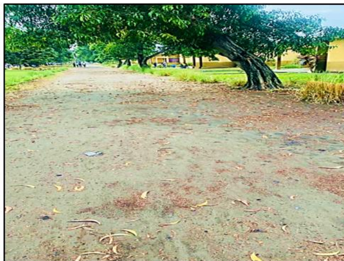
Fig. 12. Absence d'un réseau d'assainissement
