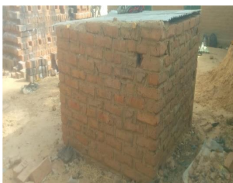
Fig. 3. Cellule expérimentale construite dans le cadre de notre étude
