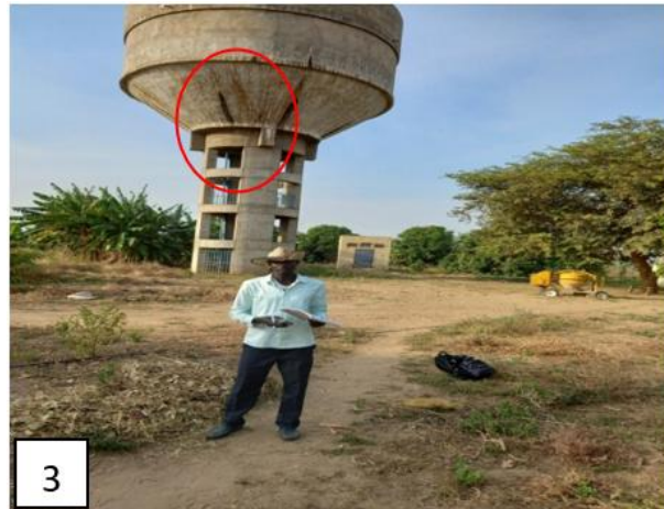
Photo 3. Réservoir fissuré
