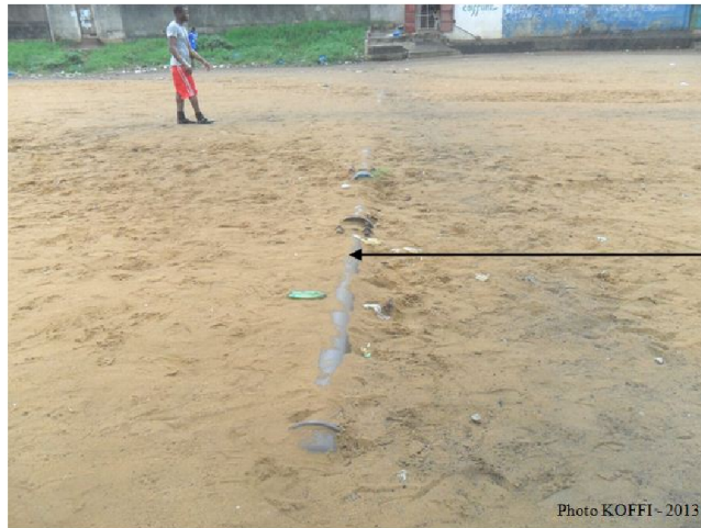
Photo 3 : Terrain de football lessivé – cité universitaire de Williamsville
