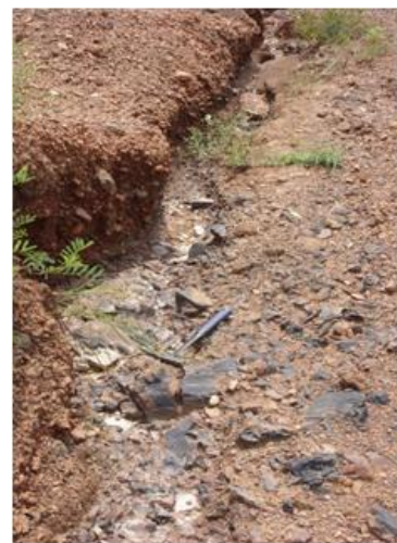
Fig. 3. Forte érosion du sol
