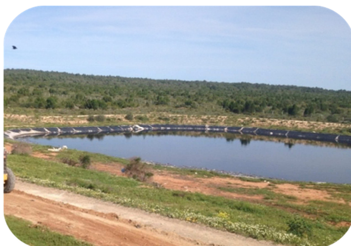
Figure3 : Bassin de stockage des lixiviats
