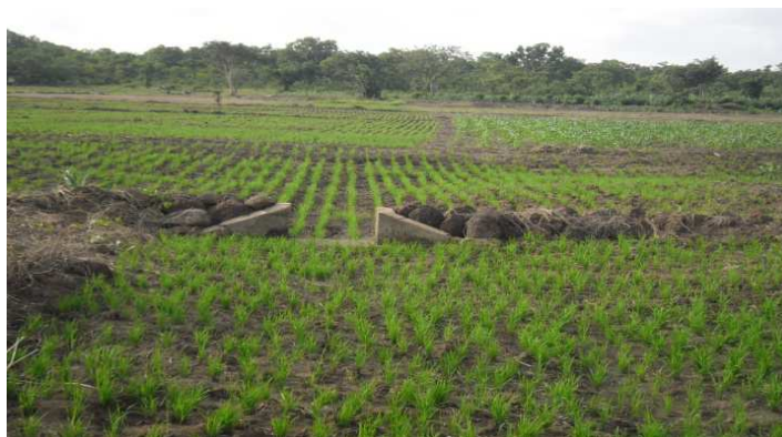
Photo 4 : Vanne de vidange ouverte
