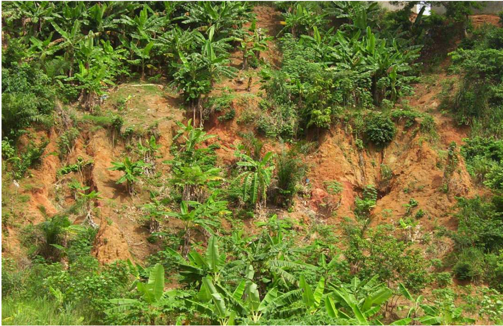
Photo 3 : Erosion de ravinement sur versant, 2005 (Mossikro, Pente, 60 %)
