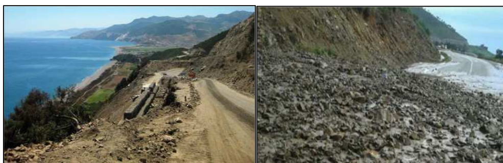
Fig. 1. Dégradation des routes marocaines par les instabilités de terrain (La rocade méditerranéenne)
