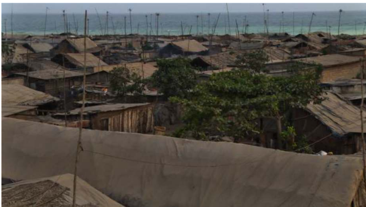
Photo : Vue partielle du quartier Katanga
