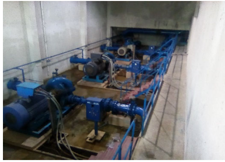
Fig. 3. Groupes motopompes de la partie refoulement
