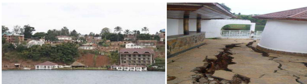
Photo 4 : Risque d'éboulement Photo 5 : Fissure de l'hôtel la Roche
