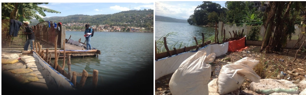
Photo 1 et 2 : Poussée de l'eau à l'aide d'une clôture, bâche et sac pourvu de la terre
