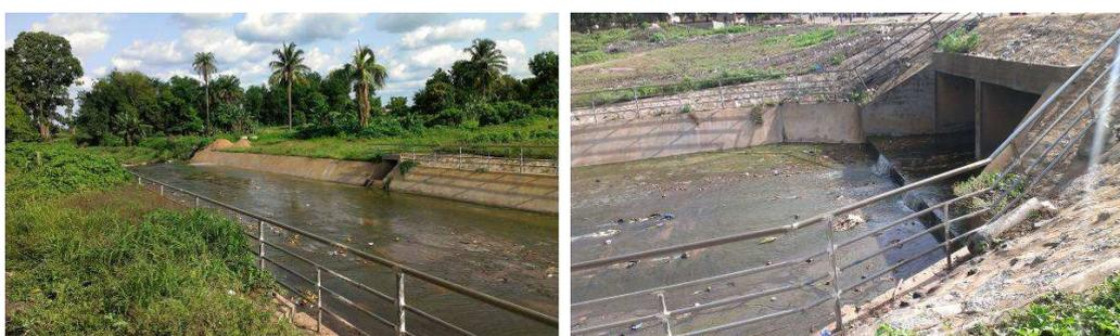
**Planche 1 : Collecteur d'eau construit sur le site maraîcher de Sinangourou (partie inférieure à gauche et partie supérieure à droite)**
