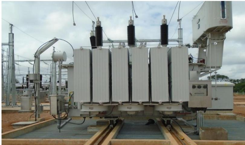
Fig. 5. Transformateur 90/30 Kv; 40 MVA a bondoukou installé en 2019 (CIE)
