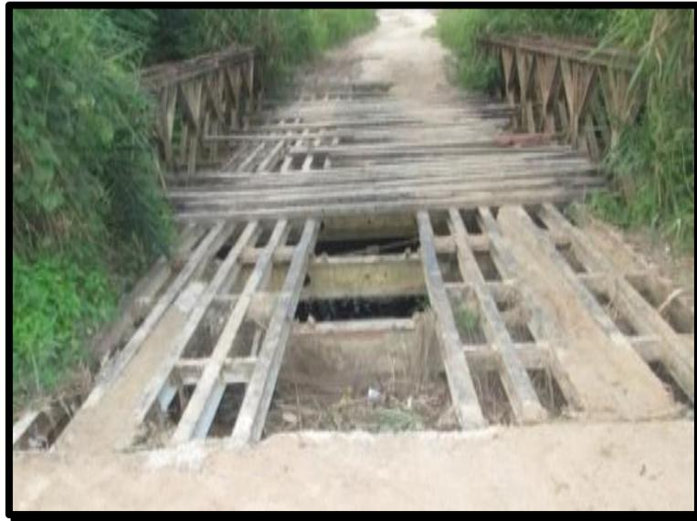
Photo 2. Vue montrant le pont métallique dépourvu de traverses, de la rivière Fidi, sur la route Kisantu-Kimvula
