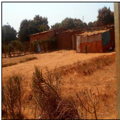
Fig. 3. Habitat précaire sur un terrain marécageux
