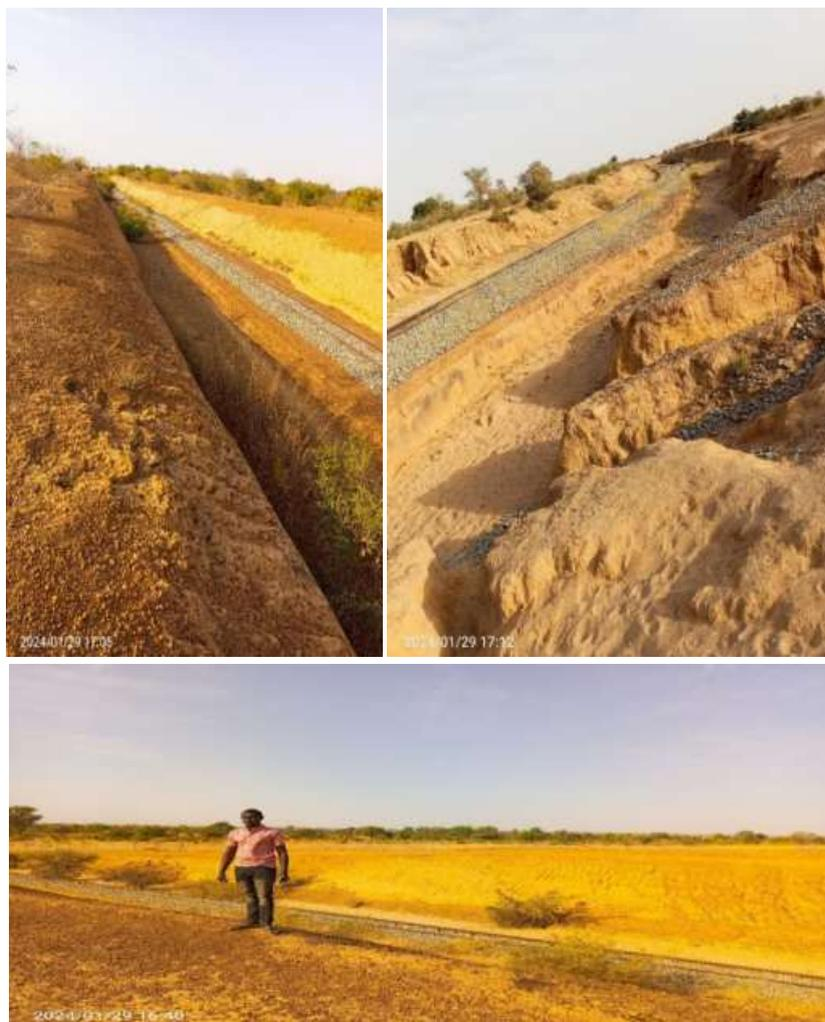
**Fig. 9.** Le chemin de fer passe par une dépression de 6,5 m d'environs et 5 m de profondeur sur une distance de plus de 500m
