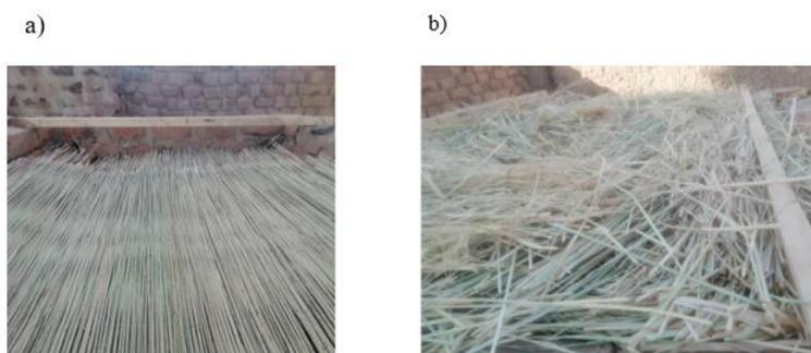
**Fig. 6. Isolation de la toiture-a) nattes de roseau à la sous face de la toiture; b) étalage des pailles du riz (échantillon 4)**
