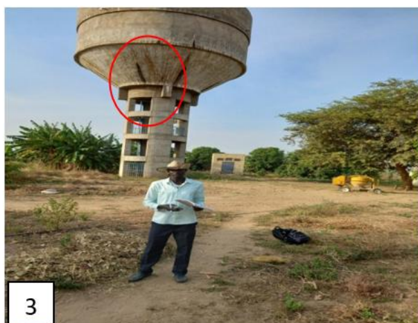
Photo 3. Réservoir fissuré
