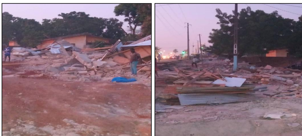
Fig. 7. Vues des méthodes et opérations de déguerpissement
