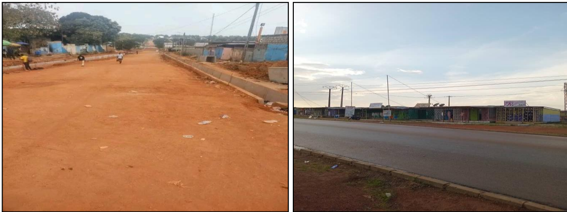
Fig. 8. Etat de la route principale du quartier Tazibouo de 2016 à 2024 (a) Etat de la voie en 2016 (b) Etat de la voie en 2024
