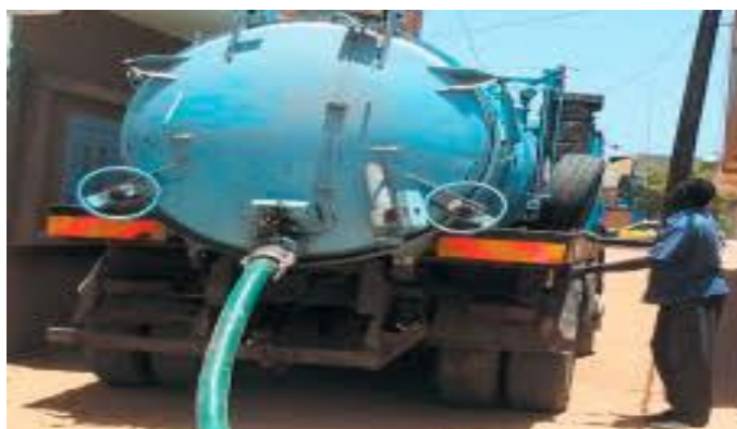
Photo 5. Vidange des eaux domestiques par les camions après le projet à Pikine
