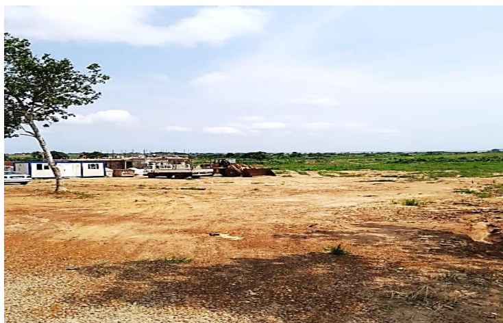
Photo 1. Nouvelle cité en construction à Songonté
