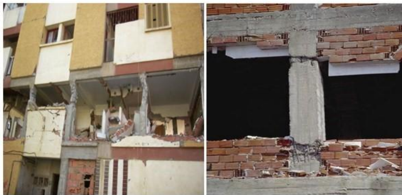
Fig. 4. Cisaillement des poteaux courts
