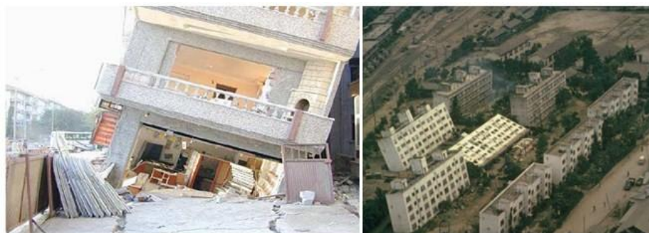
Fig. 2. Renversement de bâtiments suite à la liquéfaction du sol de fondation
