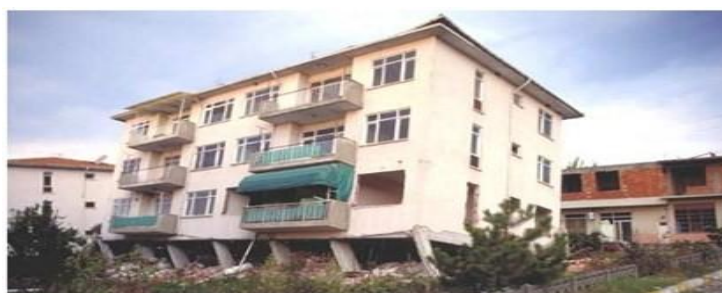
Fig. 3. Effondrement sous l'effet d'un rez-de-chaussée " souple "
