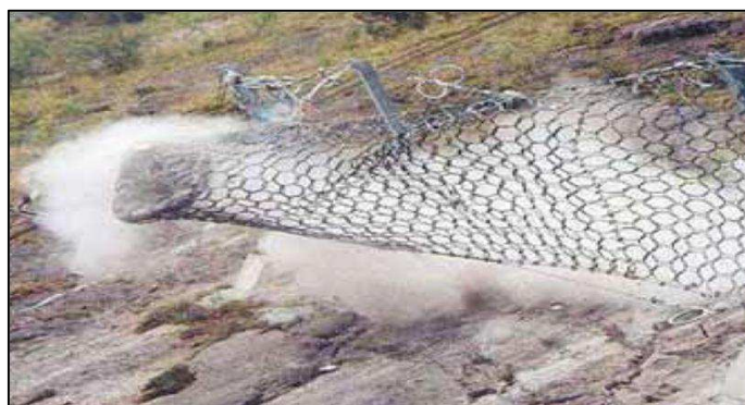
Fig. 9. Les filets métalliques en câbles d'acier sur les talus routiers
