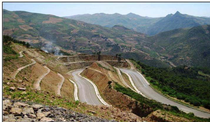
Fig. 11. Exemple de remodelage du profil instable des talus routiers
