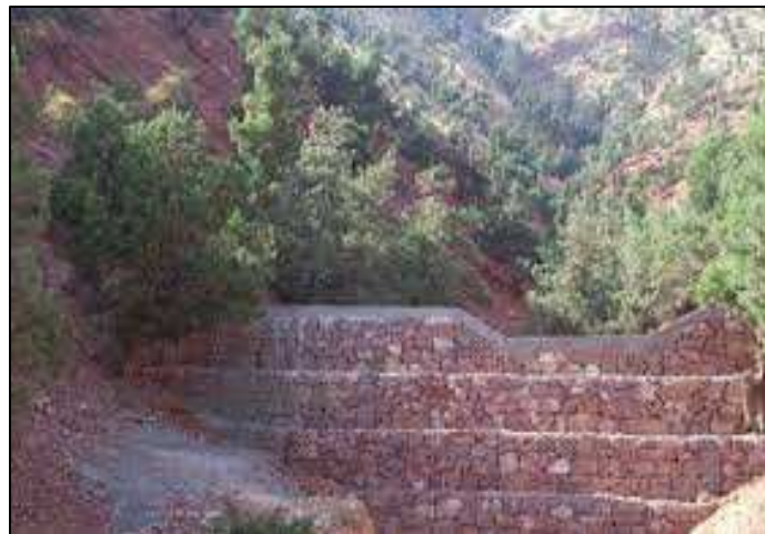
Fig. 6. Les gabions jouent un double rôle: drainage et soutènement
