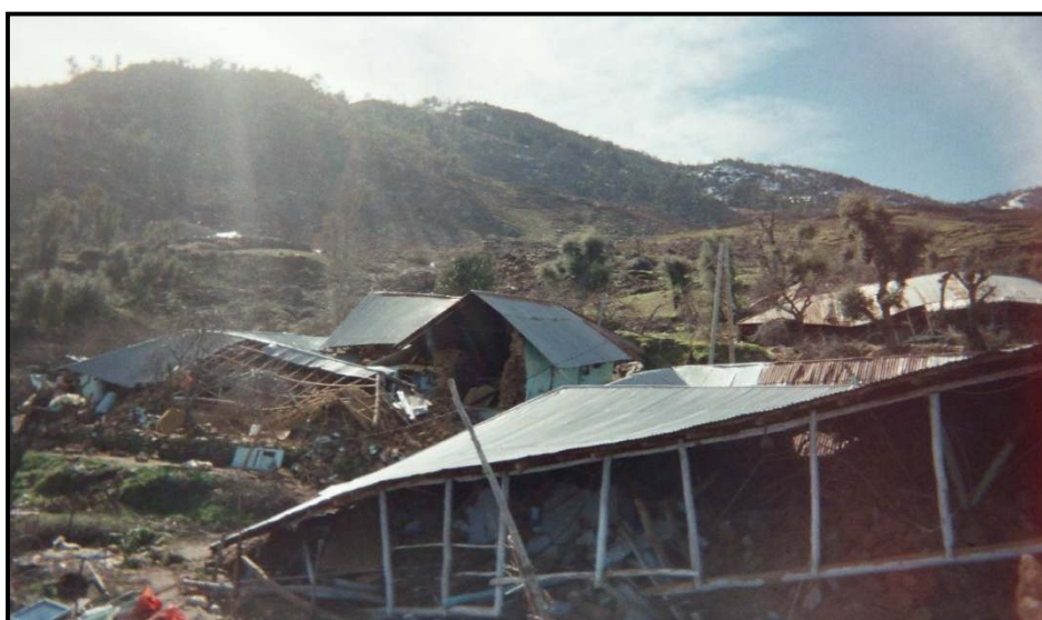
Fig. 6. Démolition de quelques maisons à cause du mouvement complexe (Observation le 06-02-2009)
