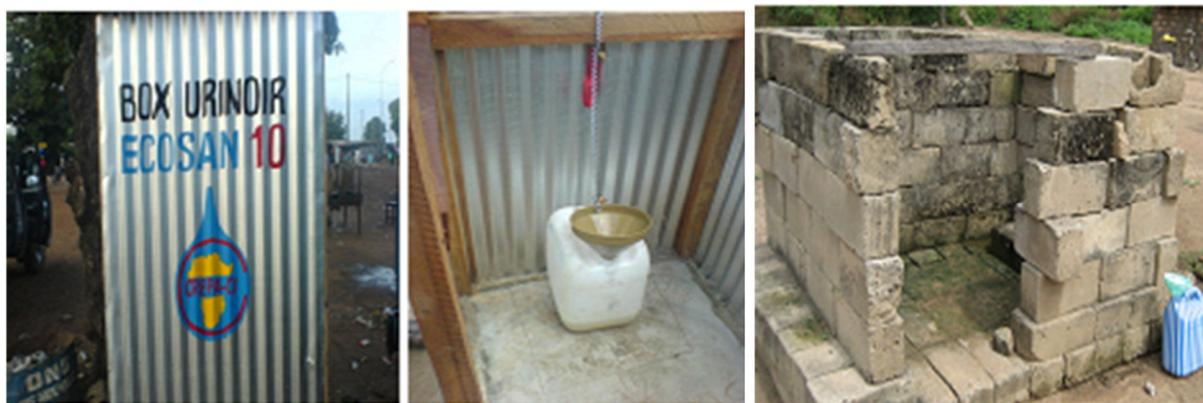
**Fig. 2.** *Box urinoir (vue de dos et de l'intérieur) et Bidurs dans une douche traditionnelle avec un dispositif de collecte des urines*
