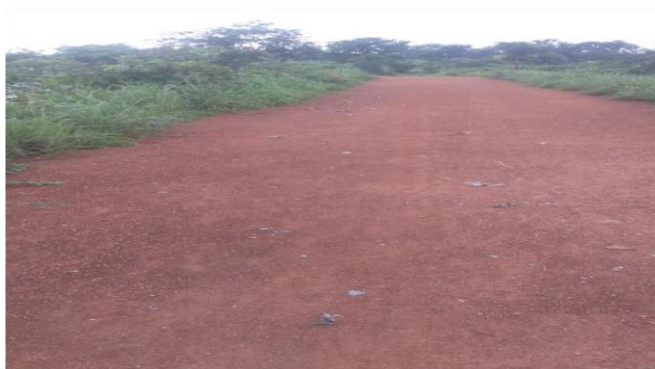
Photo 2: Digue de la retenue d'eau
