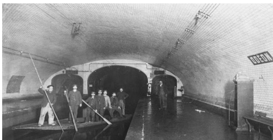
Fig. 2. Station "Odéon" inondée par remontée de la nappe en 1910, [3]
