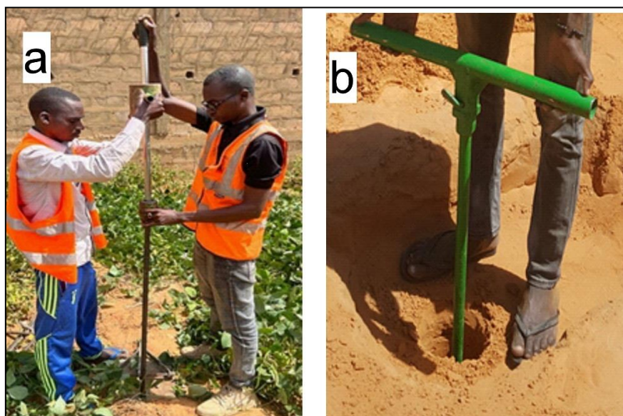
Fig. 4. (a) réalisation du sondage au pénétromètre dynamique léger (PDL) sur le site et (b) puits manuel sur le site
