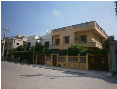
Photo n° 1 : Exemple de villas individuelles non modifiées, Lotissement Sidi Mabrouk
