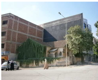
Photo n°3, source Enquête sur terrain, auteurs, 2011
