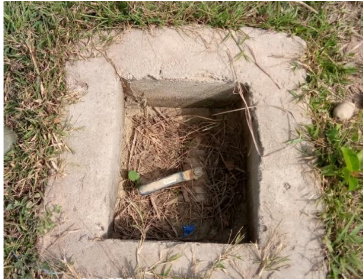
Photo 2: Vanne de réglage du débit d'eau d'un étang à la ferme Kagnon
