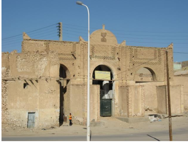
الصورة رقم 02: إحدى البوابات المتبقية من قصر مستاوة المصدر: الباحث 2018
