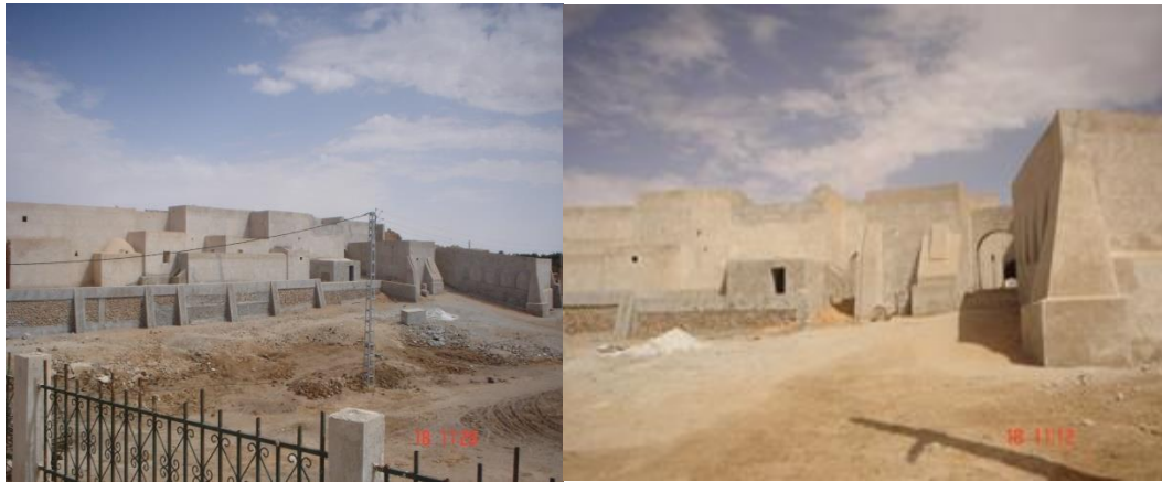
الصورة رقم 04: واجهة قصر تمرنة القديمة بعد ترميمه المصدر: الباحث 2018
