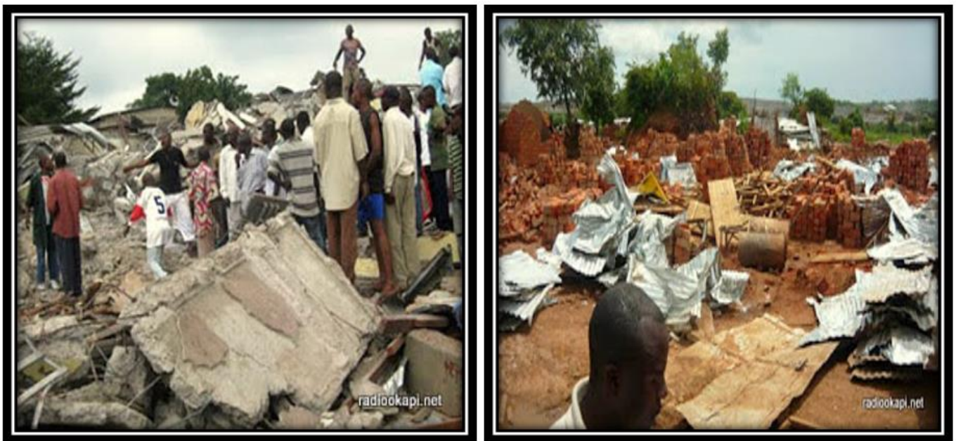
Fig. 2. Démolition des constructions anarchiques au quartier CRAA (Source: Radio Okapi, 05/01/2011)
